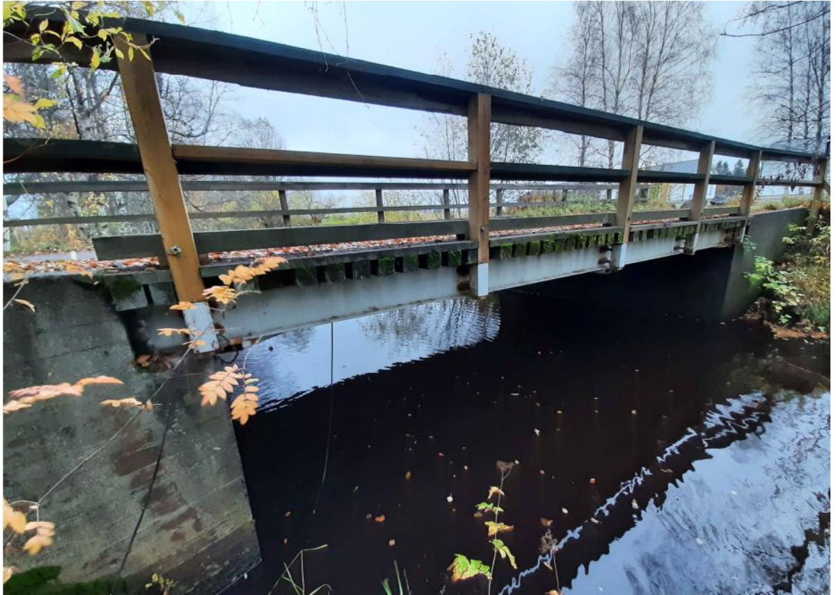
Yleiskuva vasemmalta puolelta.
