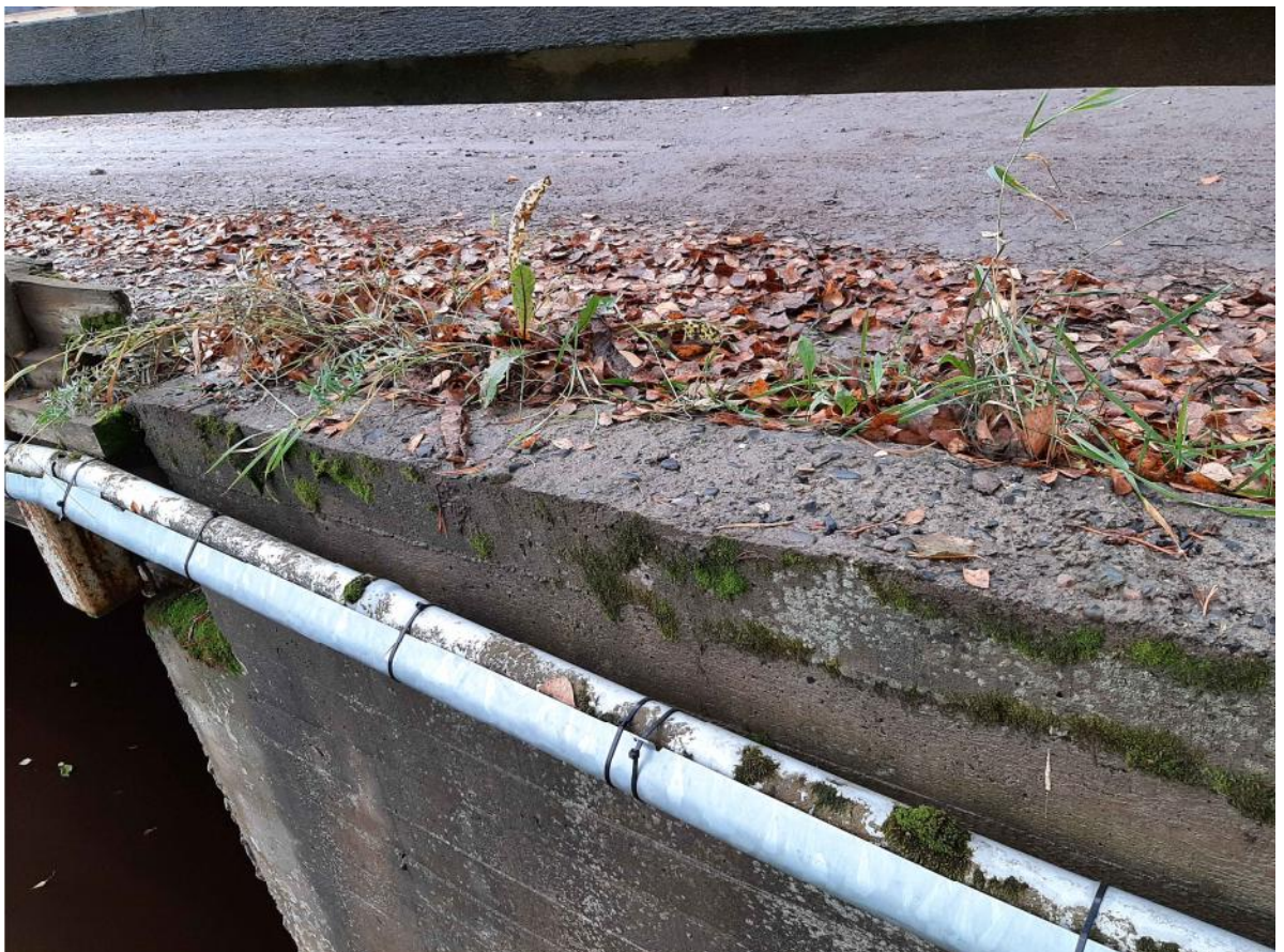
Kuva 2, Siipimuurien päällä on rapautumaa, maa-aineksia ja kasvustoa.
