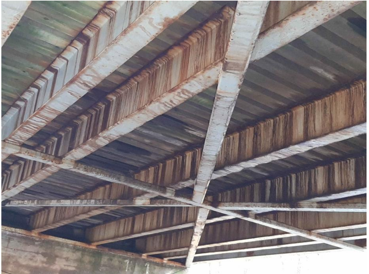
Yleiskuva sillan alta.
