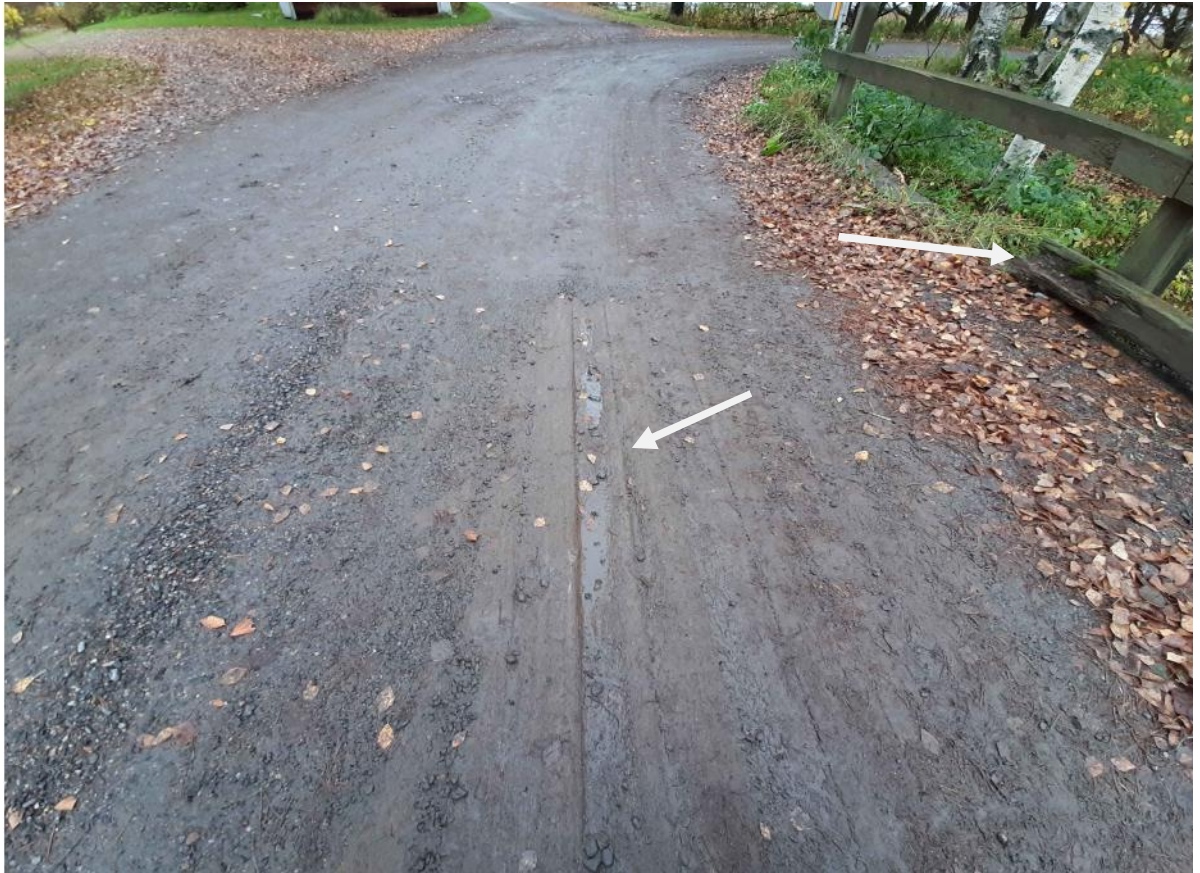
Kuva 8 Kansilankutuksessa on vakavaa kulumaa. Sillan kannella on maa-aineksia. Oikean puoleisen suisteparrun pästä on lahonnut osa pois.
