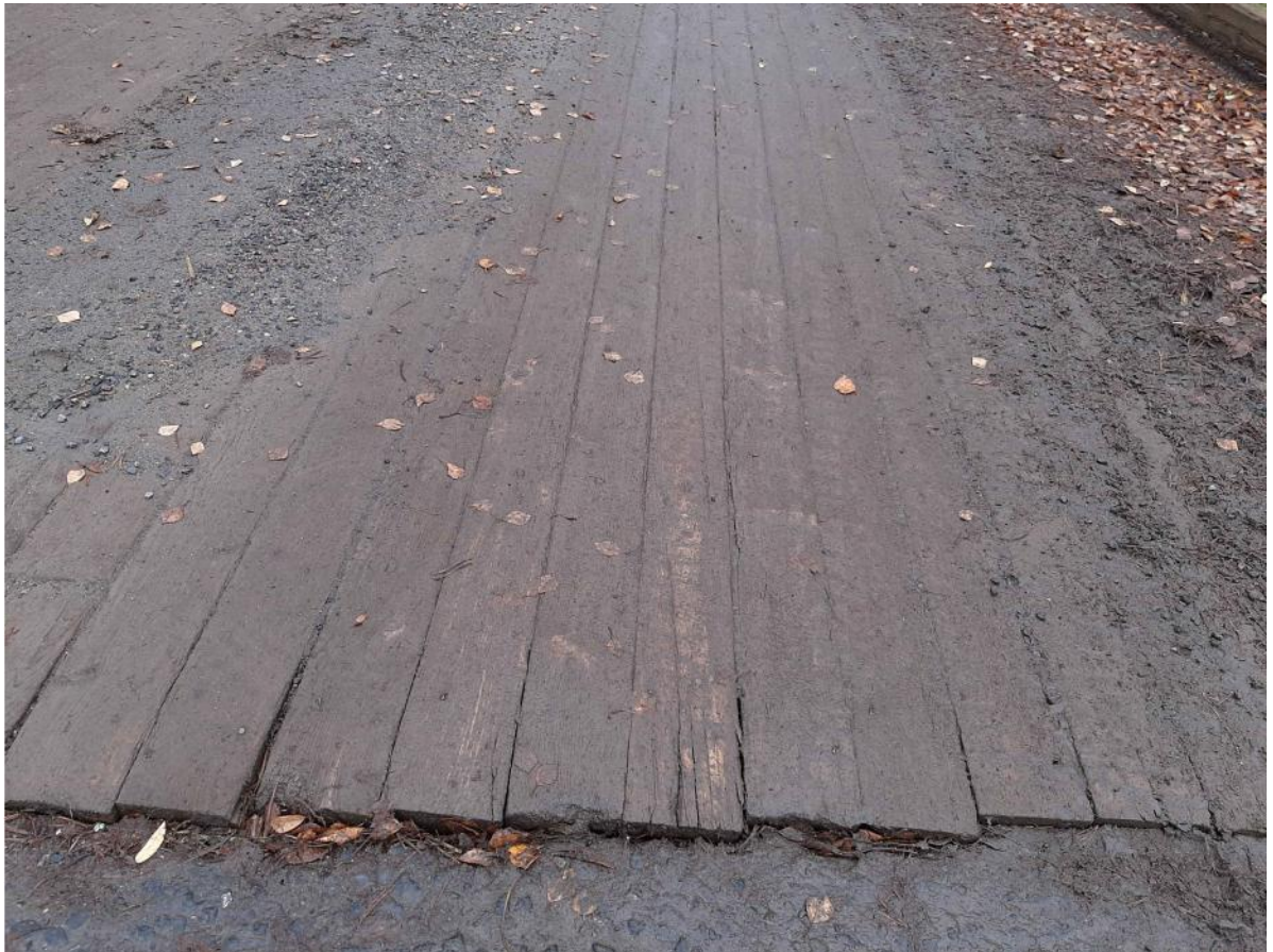
Kuva 7 Kansilankutuksessa on merkkejä lankutuksen liikkeistä (naulat irtoamassa). Osa lankkujen päistä on halki.
