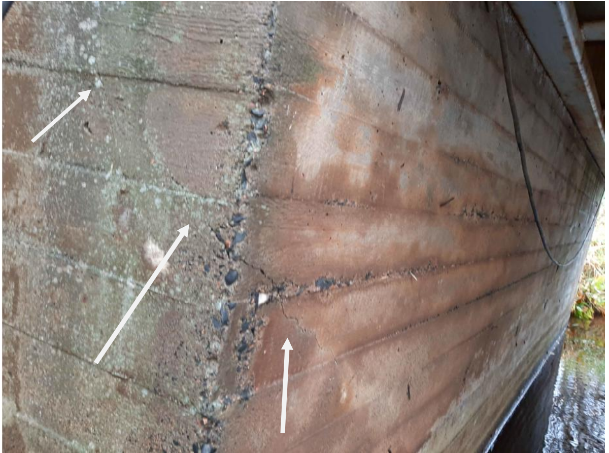
Kuva 1, Siipi- ja etumuurien halkema laakeritason sisäkulmasta etumuuriin.
