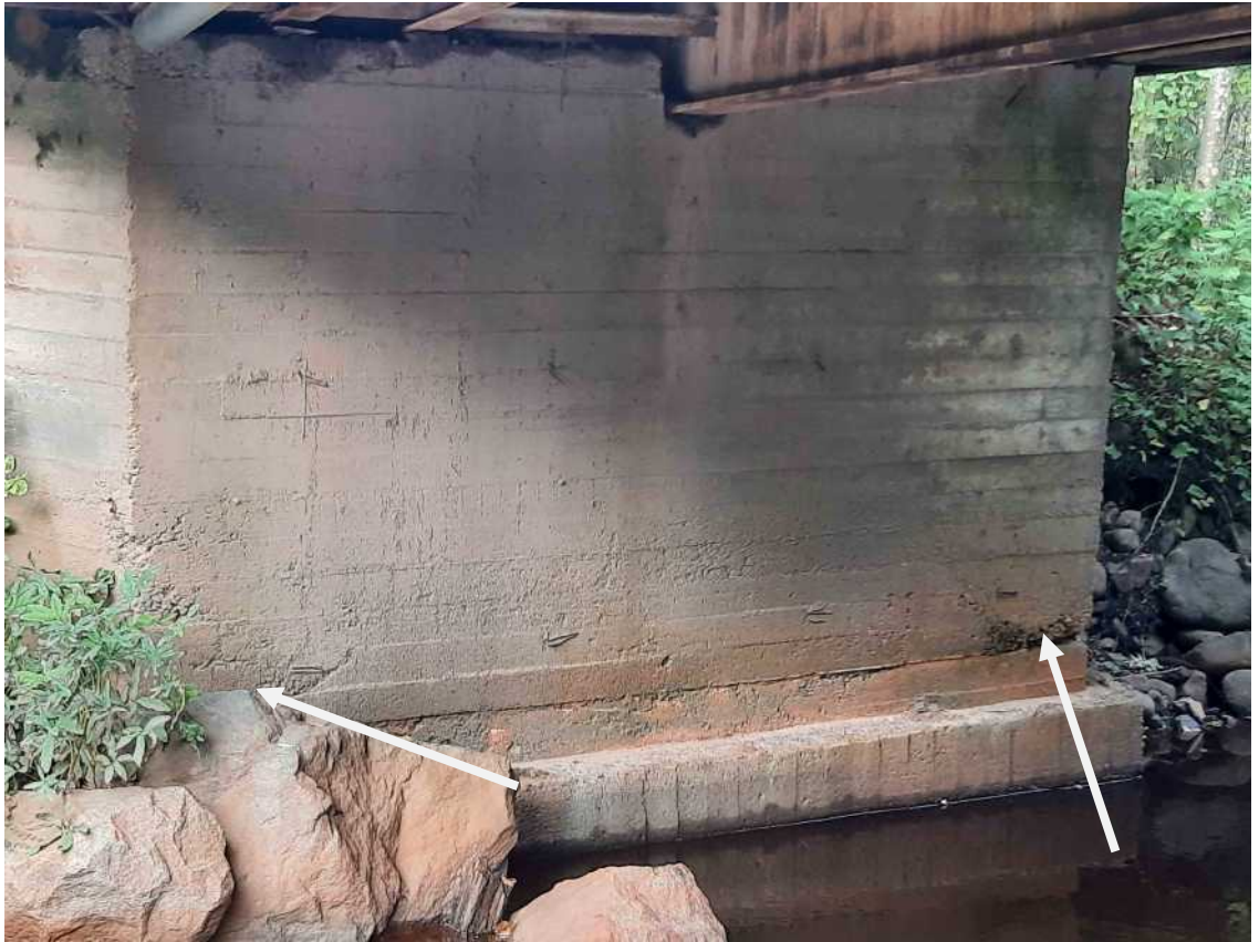
Kuva 1, Siipi- ja etumuurien rapautumaa ja harvaa valua.
