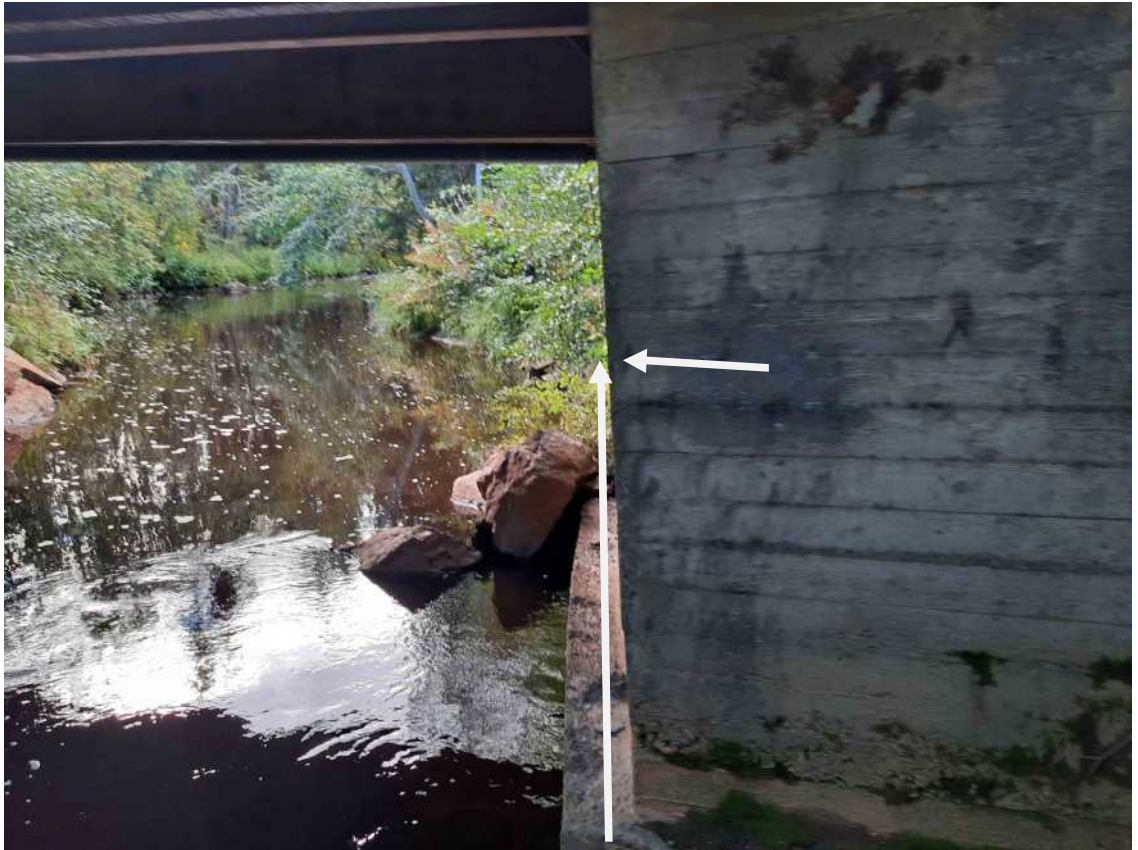
Kuva 3, Tuen 1 maatuen kallistuma eteenpäin ~100-150 mm.
